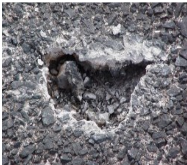
Figura 4 – Efeitos da cavitação no vertedouro da Itaipú binacional.
