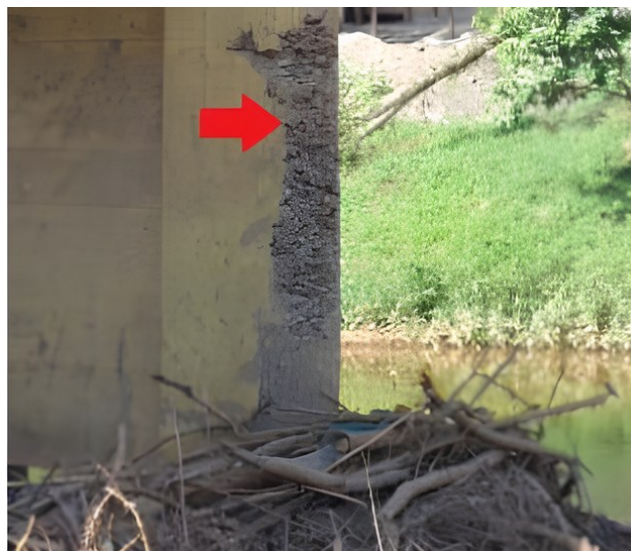
Figura 3 – Efeito da abrasão na superfície do pilar.
